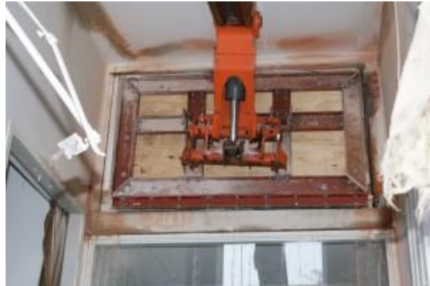
Foto links: Van Kempen staat klaar om te zagen Foto rechts: Het frame is aangebracht, de kraan zit vast
